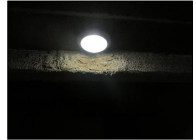
Photo N° 939 AMIANTE CIMENT -- LOCAL VO -1 Gainés & coffres horizontaux Ventilation haute (Fibres-ciment)
